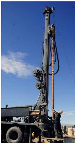
Au vu des conclusions de ce diagnostic, le syndicat a choisi de réhabiliter le forage. Les travaux consisteront à rechemiser la partie supérieure du captage jusqu'au sommet de la colonne captante. Cela empêchera les arrivées d'eaux superficielles relativement plus chargées en nitrates et pesticides.
