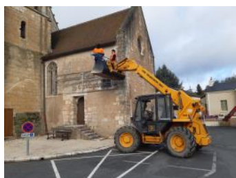
Mise en place des décorations de Noël
