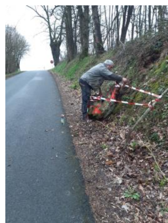
Enlèvement d'une souche dangereuse
