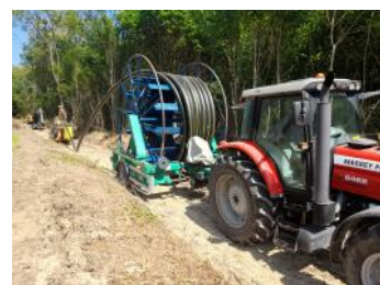
Assistance à la pose du réseau de gaz
