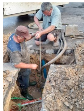
Réparation de fuite
